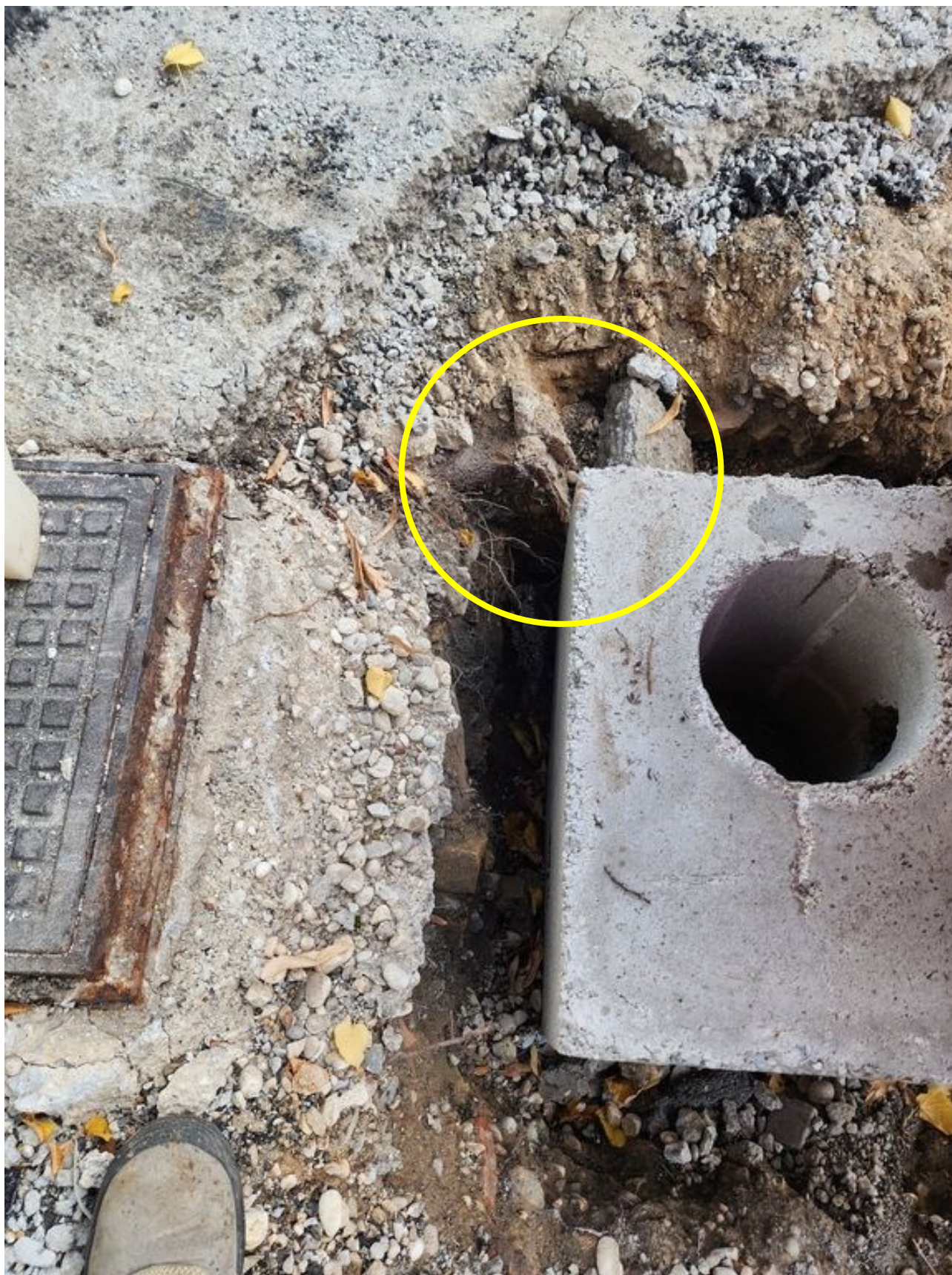
Figura 7: particolare della radice in prossimità del sottoservizio a Sud
