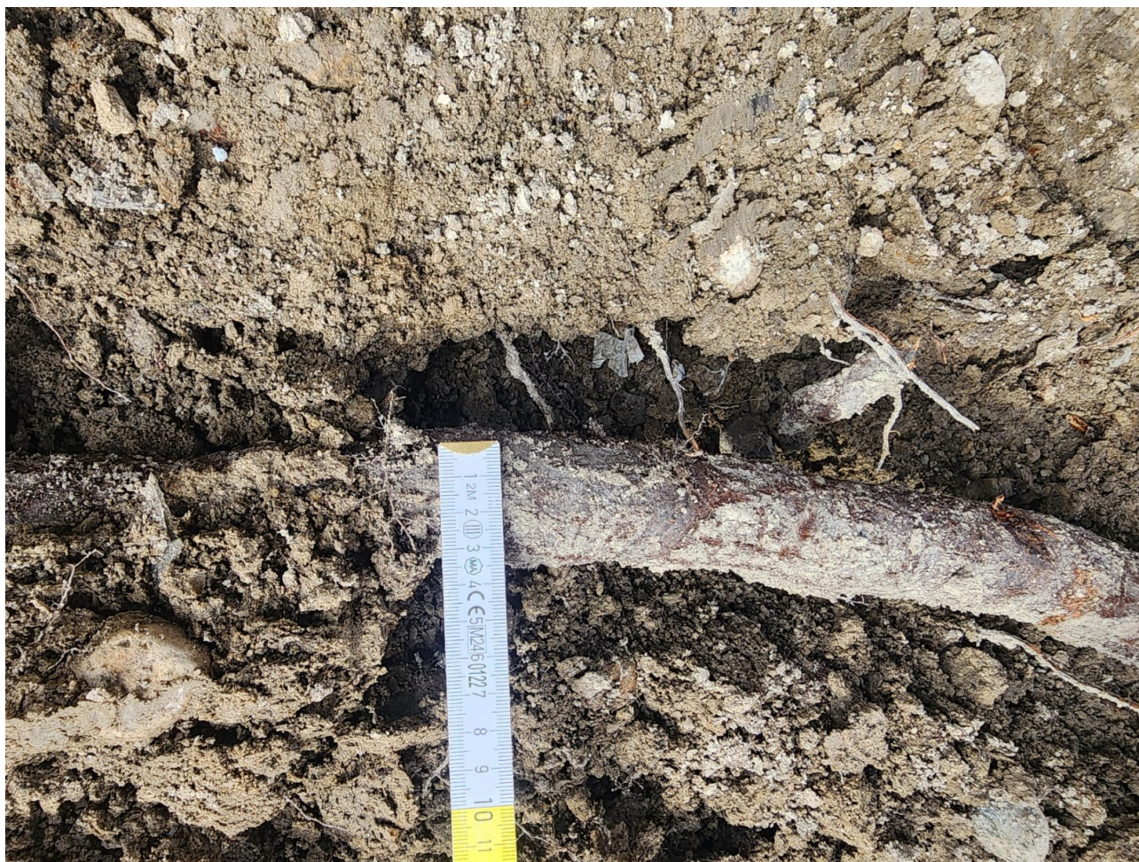
Figura 14: radice rinvenuta nello scavo del plinto di 3-4 cm
