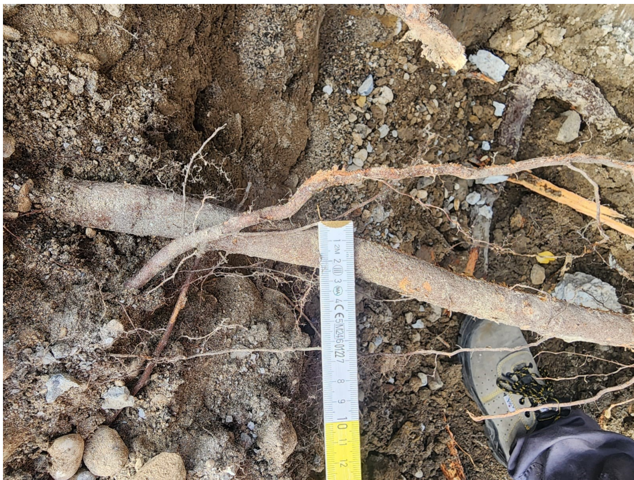
Figura 16: particolare della radice rinvenuta nel plinto di 2-3 cm
