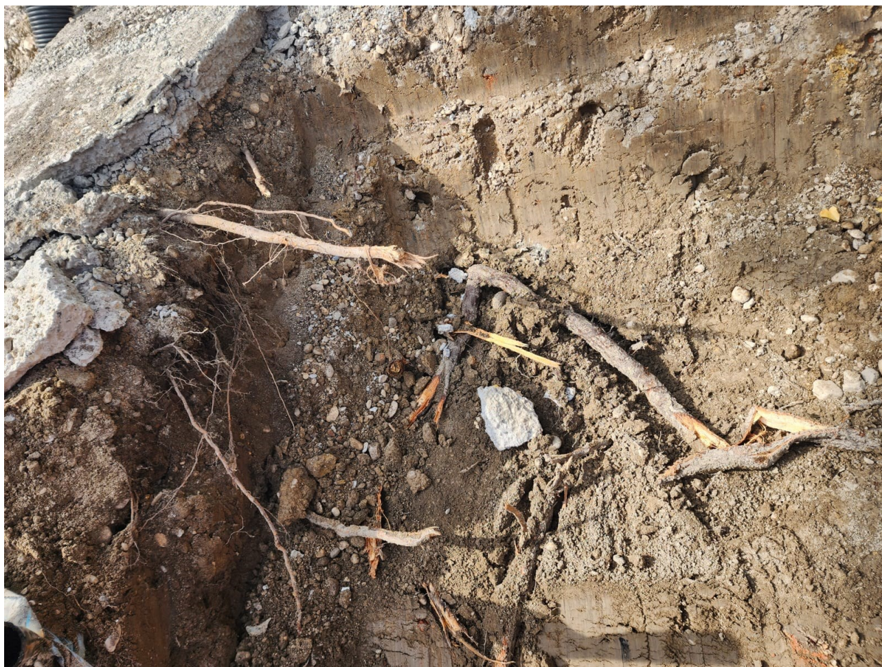
Figura 10: particolare delle radici presenti nell'area di scavo del plinto
